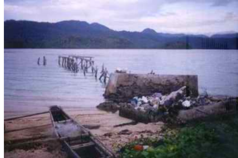
Sarana Pelabuhan yang rusak di kampung Yomakan
