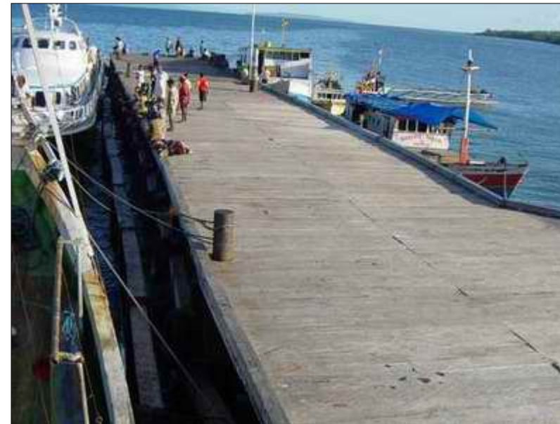
Sarana Pelabuhan yang ada di kabupaten Teluk Wondama
